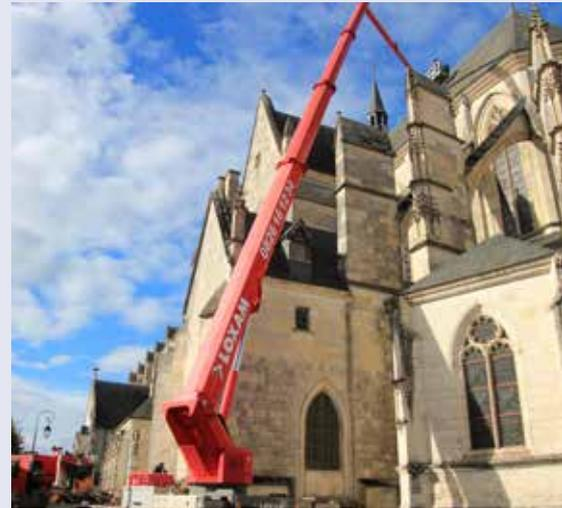
LE CHANTIER URGENT DE RÉFECTION DU TOIT DU CHEVET DE LA BASILIQUE A ÉTÉ RÉALISÉ COURANT NOVEMBRE. IL S'AGISSAIT DE REMETTRE LES TUILLES DISPARUES OU ABIMÉES POUR METTRE À L'ABRI LA CHARPENTE DE CETTE PARTIE DU TOIT.
